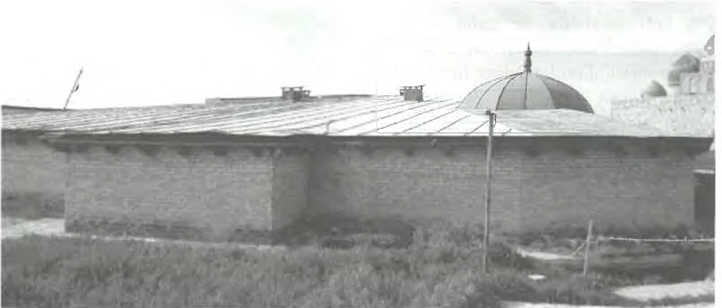
Hilvet kilt binası. Türkistan şehri.
