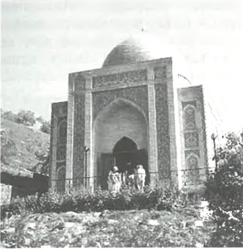
Akbura Evliya Türbesi.
