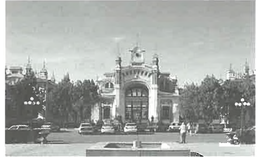
Türkistan Demiryolu İstasyonu.
