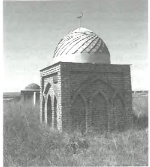
Maylıkoja'nın Türbesi. 20. asrın sonu.
